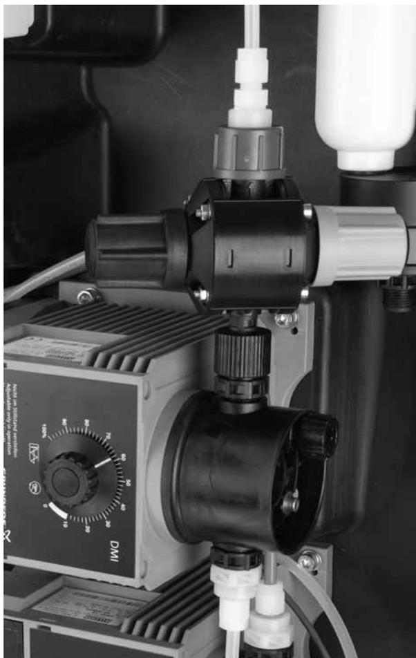
Рис. 33 Многофункциональный клапан на дозирующем насосе (также см. рис. 42, поз. 26, стр. 139).
