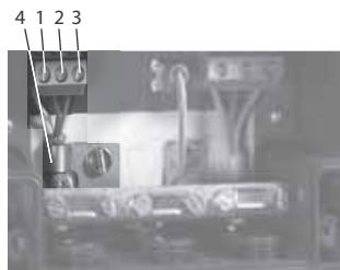
**Рис. 5** Подключение GENIbus
