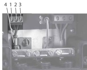
Fig. 5 Connexion GENibus
